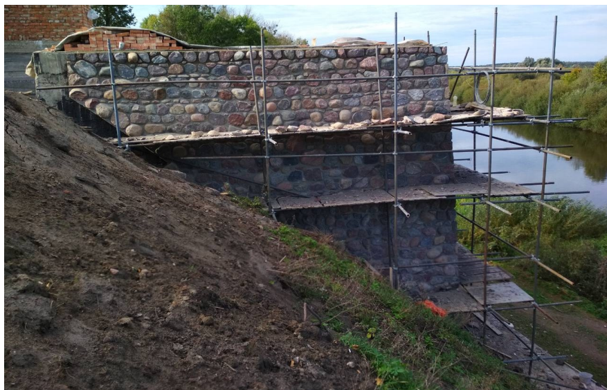
Восстановленная стена на основе фундамента XVII в.
