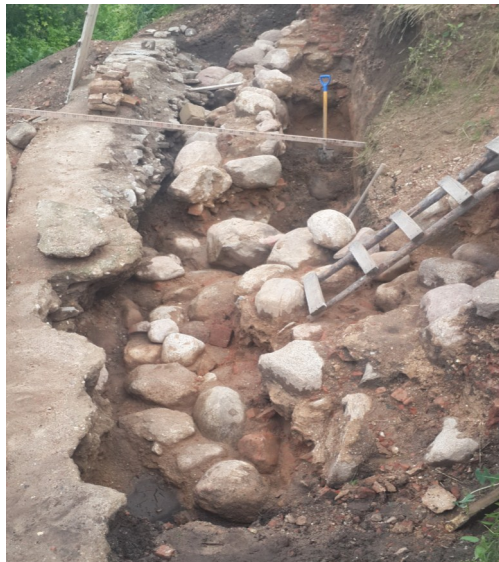
Фундамент XVII в. (до восстановления)
