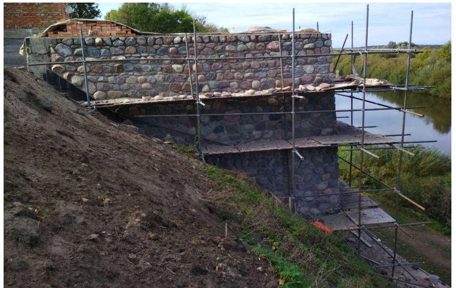
Восстановленная стена на основе фундамента XVII в.
